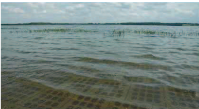
Rys. 15. Napelniony zbiornik Kopalni „Machów”- widoczne przeciwbazyjne umocnienie skarby zachodniej
