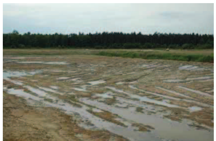
Rys. 19. Wyróbisko po rekultywacji technicznej-usunięciu mas ziemi zanieczyszczonych siarką
