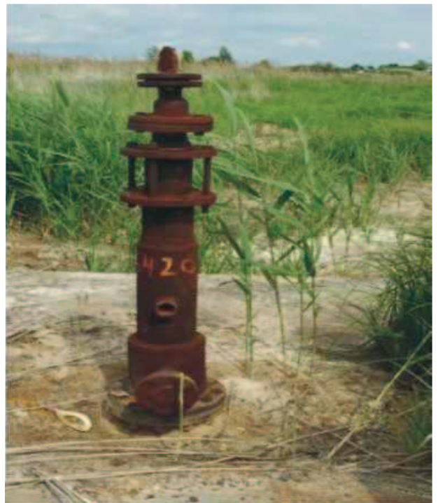
Rys. 18. Otwór eksploatacyjny siarki do likwidacji
